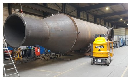
Revamping de la chaudronnerie d'une unité d'incinération site chimique
